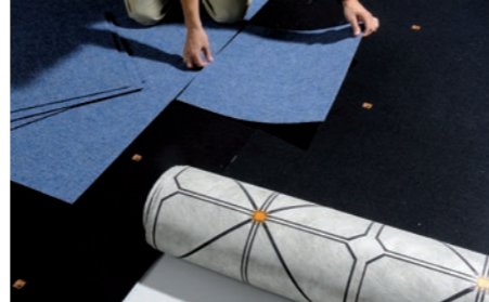
Abb. 1: SensFloor ist unter flexiblen Bodenbelägen wie PVC, Teppichboden oder unter starren Belägen, wie Laminat und Parkett verlegbar.
