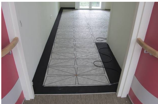
Abb. 3: SensFloor nach seiner Installation im Patientenzimmer, vor der Installation des eigentlichen Bodenbelags (hier PVC).
